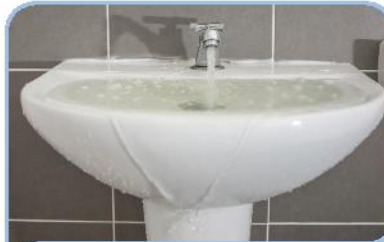
إنفجار مواسير المياه
